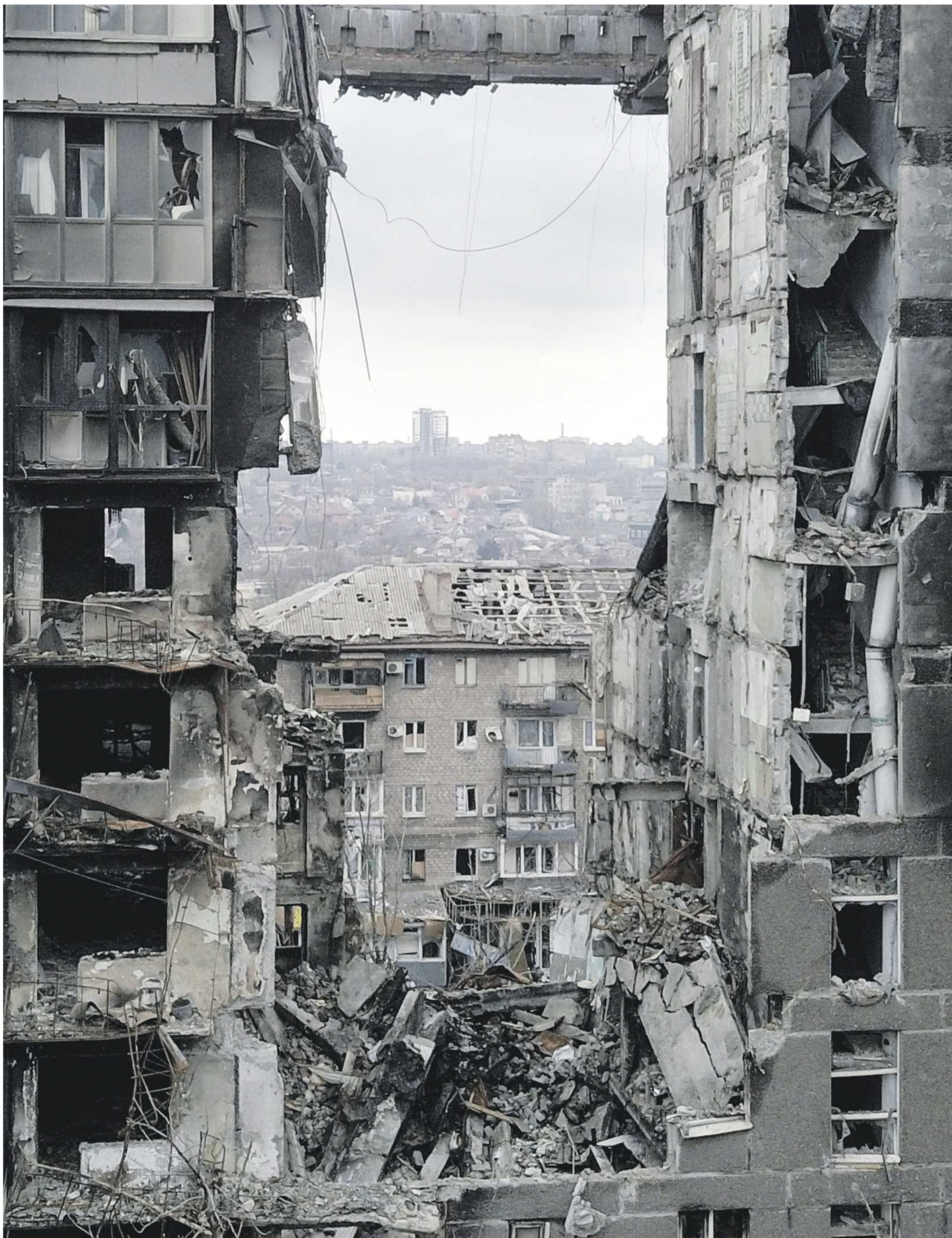
Aufnahme eines zerstörten Wohnhauses in Mariupol, Mitte April
